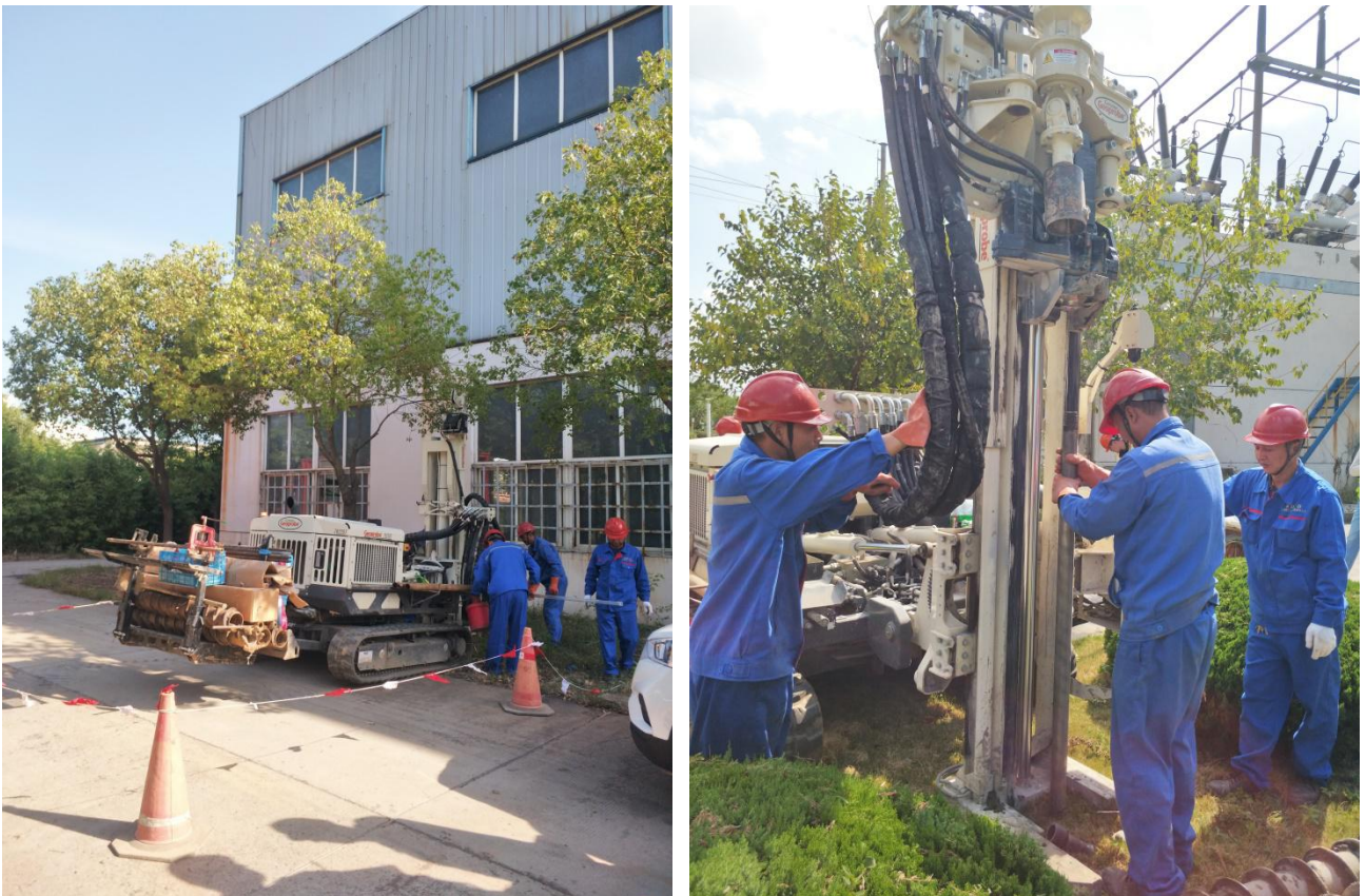
图 5.2 Geoprobe 设备采集土壤
