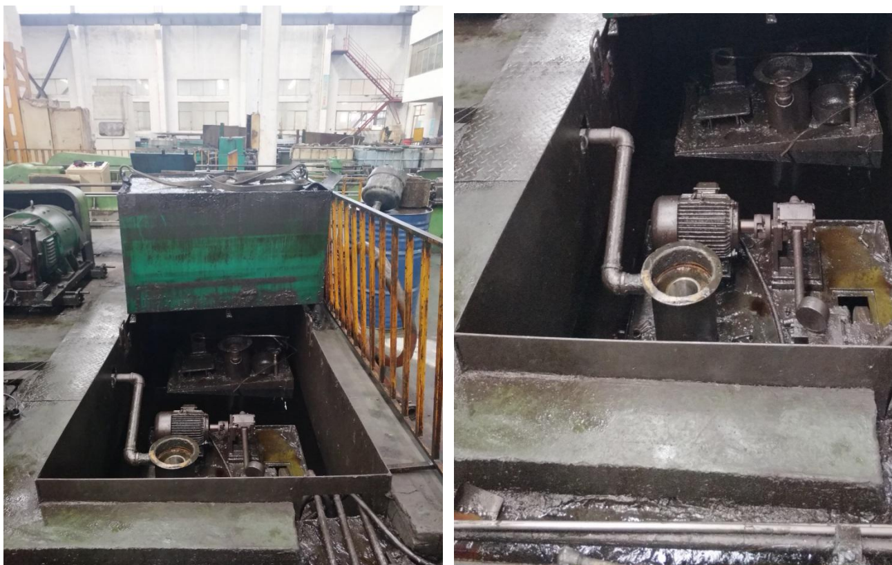
图 3.1 精轧车间内储槽及防护情况
